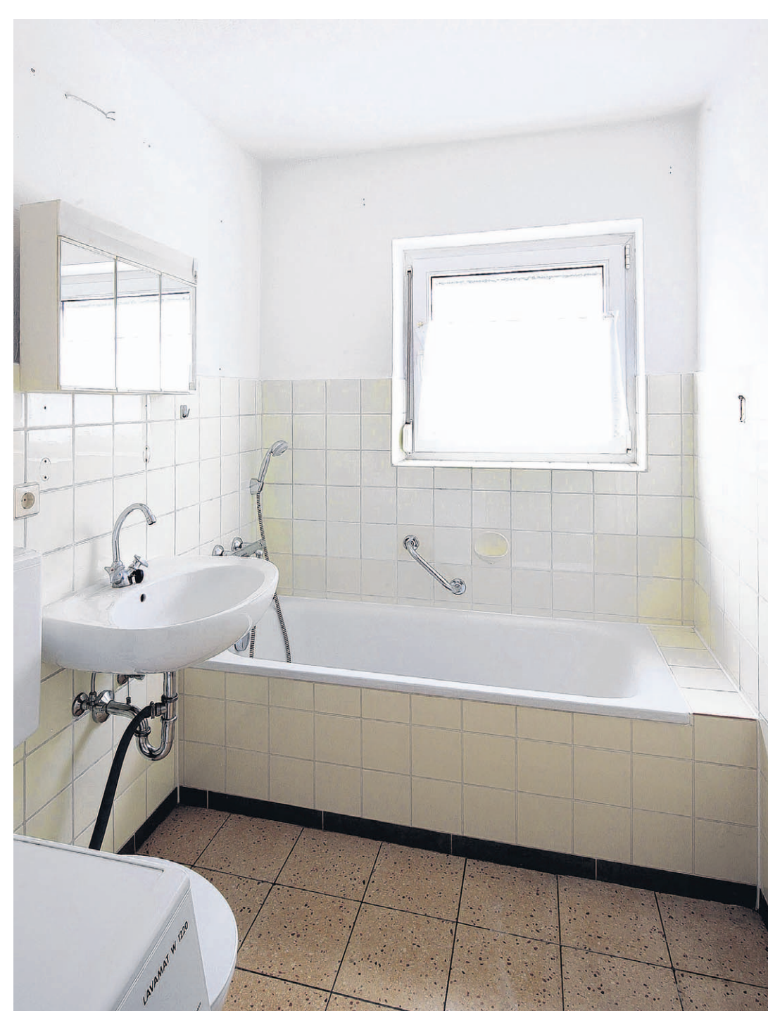
Die Bäder mit ihrem typischen Grundriss der 60-er Jahre vor der Renovierung. BILDER: ARTWEGER
