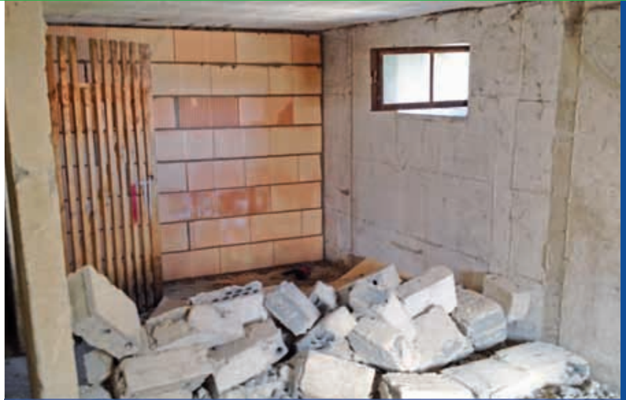
Selbst im Keller der Jacques-Schiesser-Straße 2 werden die Räume für künftig acht Wohnungen angepasst. Dazu müssen Mauern fallen.
