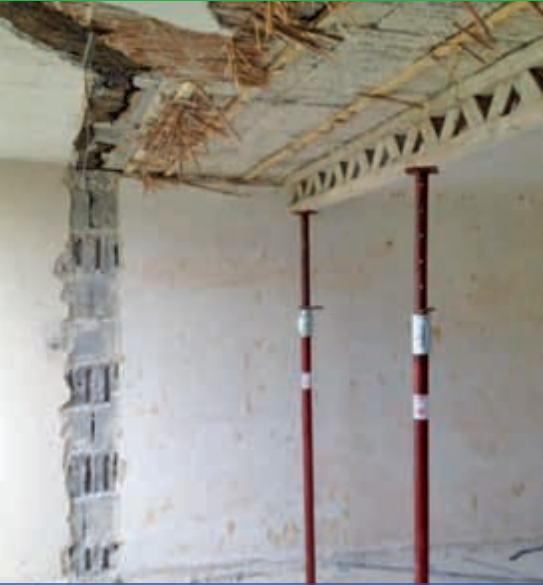
Die HEGAU versetzt das Haus zurück in den Rohbauzustand, manche Baumethode von einst wird hier augenfällig.
