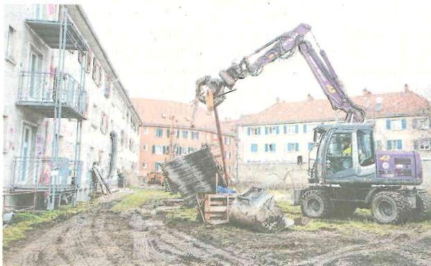
Der Holzschopf ist für Baggerführer und Bagger eine leichte Kost. Die Häuser hingegen müssen Stück für Stück abgetragen und die Materialien nach Sorten entsorgt werden.
