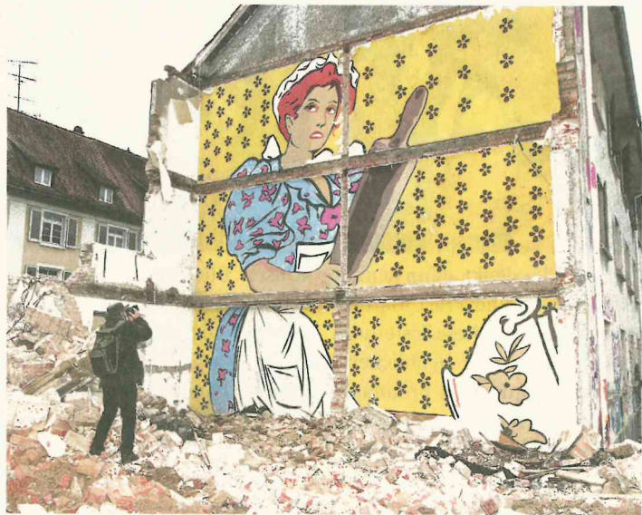
Dieses Motiv des Künstlers Bert Binning wurde am Samstag durch den Teilabriss freigelegt. Es ist nur wenige Tage in dieser Form zu sehen. swb-Bild: uj
