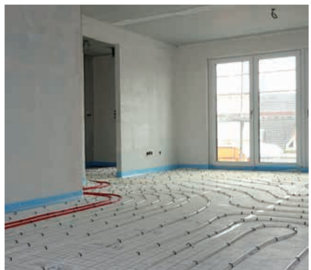
Die Fußbodenheizung ist verlegt
