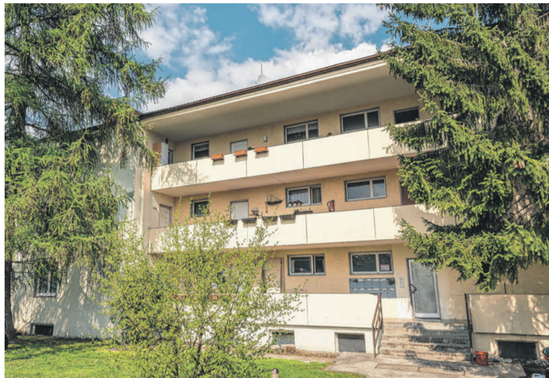
Vorher: Das Gebäude in der Königsbergerstraße 2 vor der umfassenden Modernisierung. Der Eingang war nur über eine Treppe erreichbar und auch ein Aufzug war nicht vorhanden. BILD: BGH
