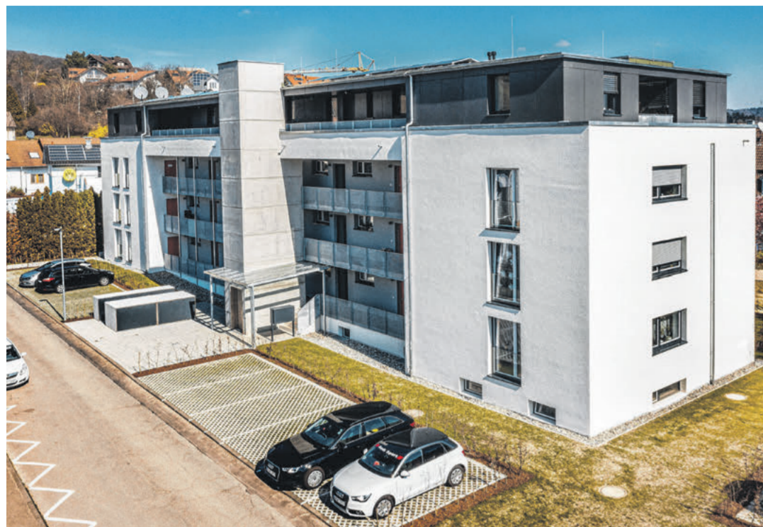
Nachher: So sieht das Gebäude in der Königsbergerstraße 2 in Stockach jetzt aus. Im Bild die Vorderseite mit Eingangsbereich und Aufzug. BILD: WÖHRSTEIN FOTOGRAFIE, SINGEN
