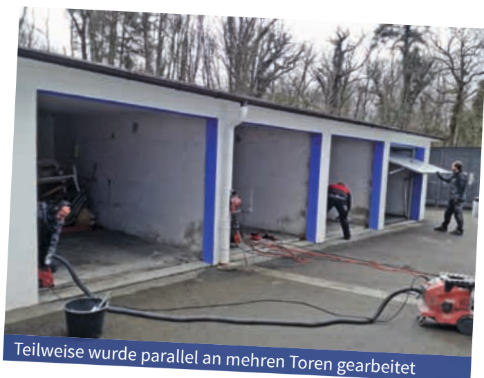
Der Estrich wird für das neue Schwellenisen aufgeflext
