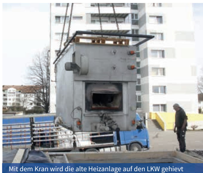
Demontage und Ausbau des alten Ölkessels
