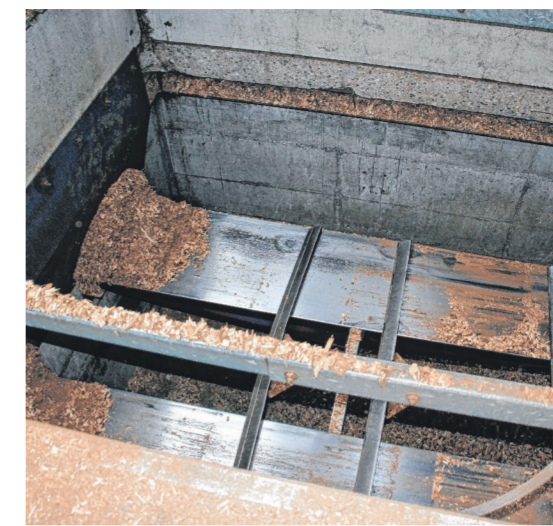
Blick in das Holz hack- und Sägestückholzkessel auf die Fördereinrichtung.
