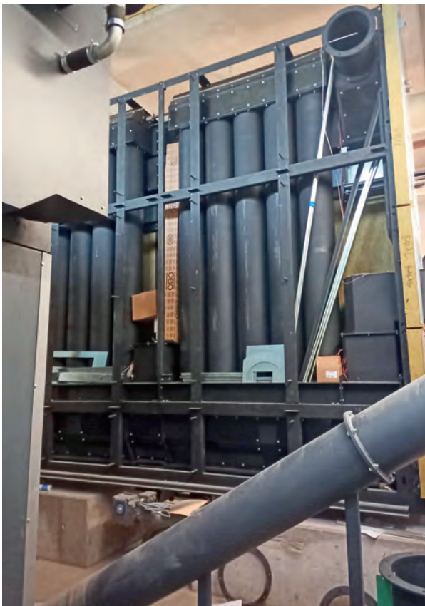
Die Filteranlage der erneuerten Holzhackschnitzelheizzentrale „fängt“ rund 97 % des Feinstaubes ein
