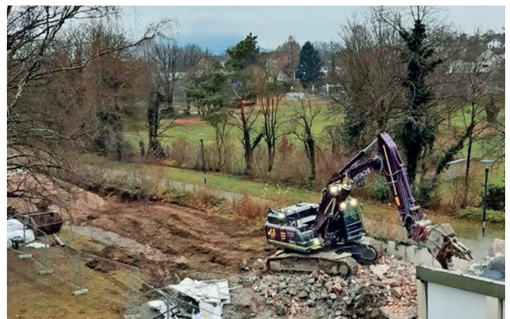
Baggerbiss als Startschuss des Baus "Überlinger Höfe"
