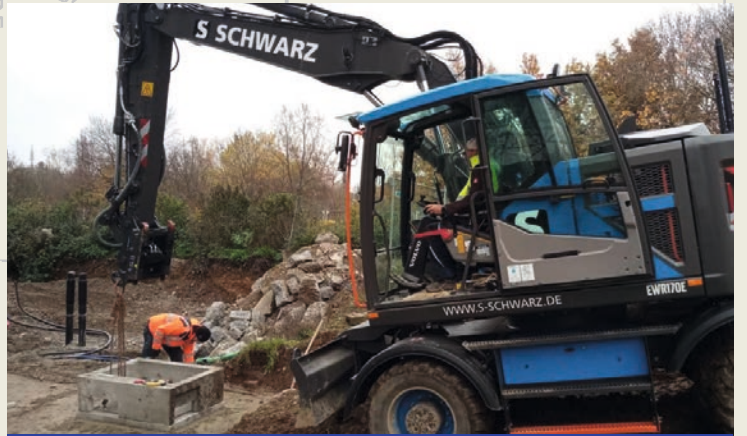
Der Bagger bei der Arbeit
