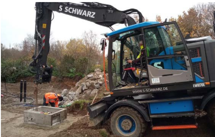
Der Bagger bei der Arbeit
