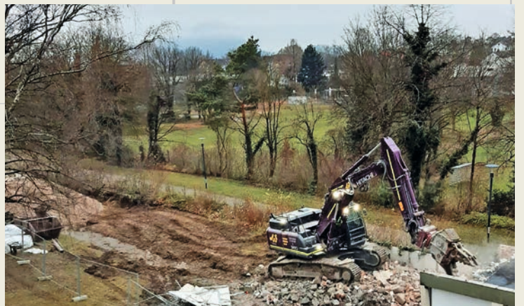
Baggerbiss als Startschuss des Baus "Überlinger Höfe"
