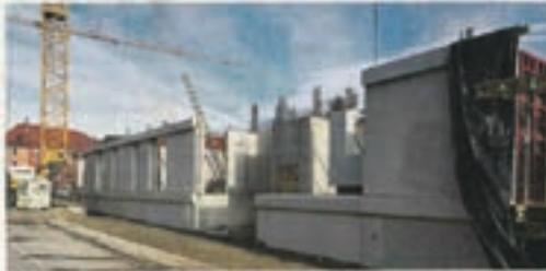
Die ersten Fertigbauteile werden montiert, um die Praxedisgärten auszubauen. Foto: BSG Baugenossenschaft Hegau
