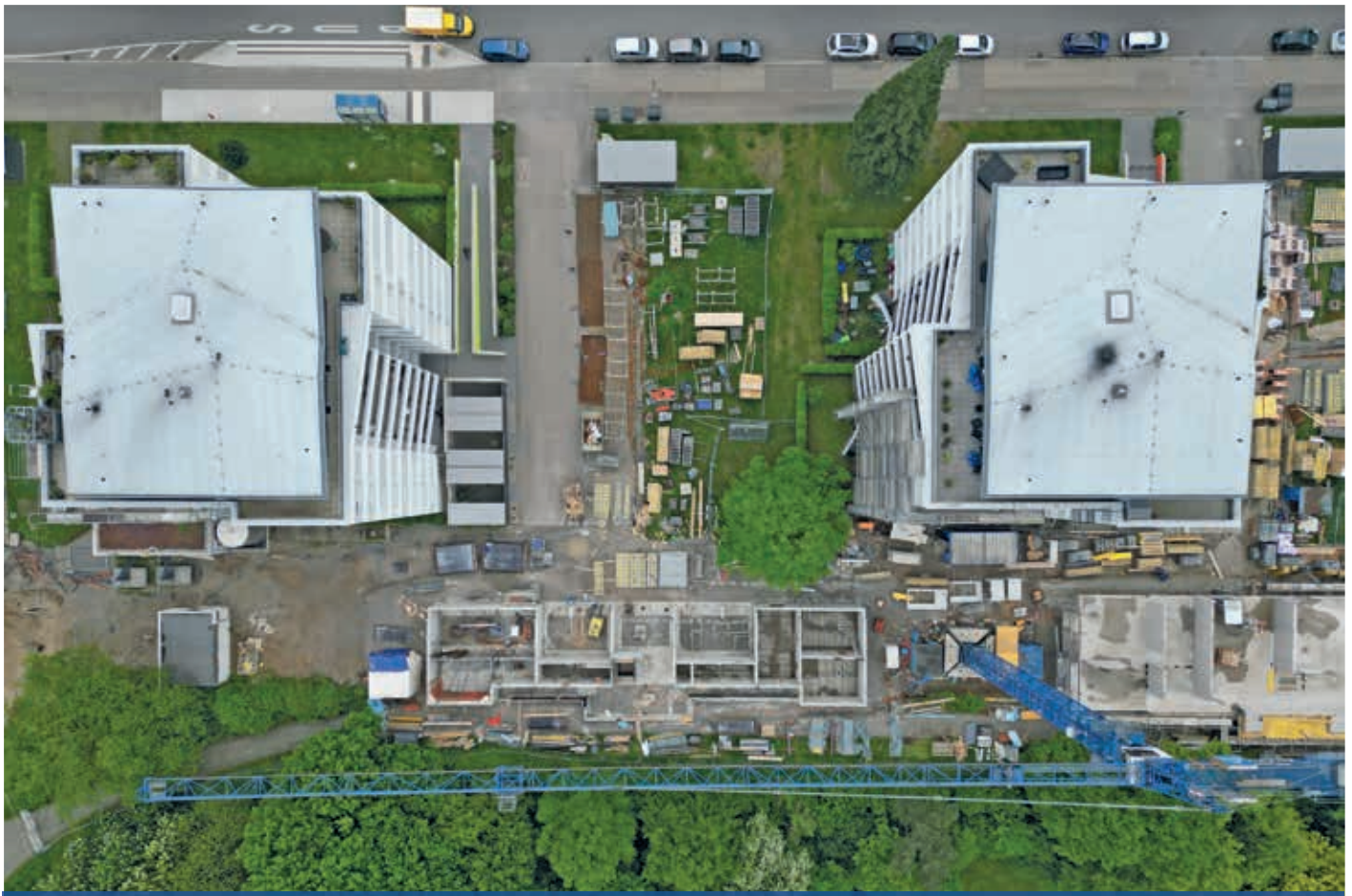
Die Baustelle in der Überlinger Straße aus der Vogelperspektive
